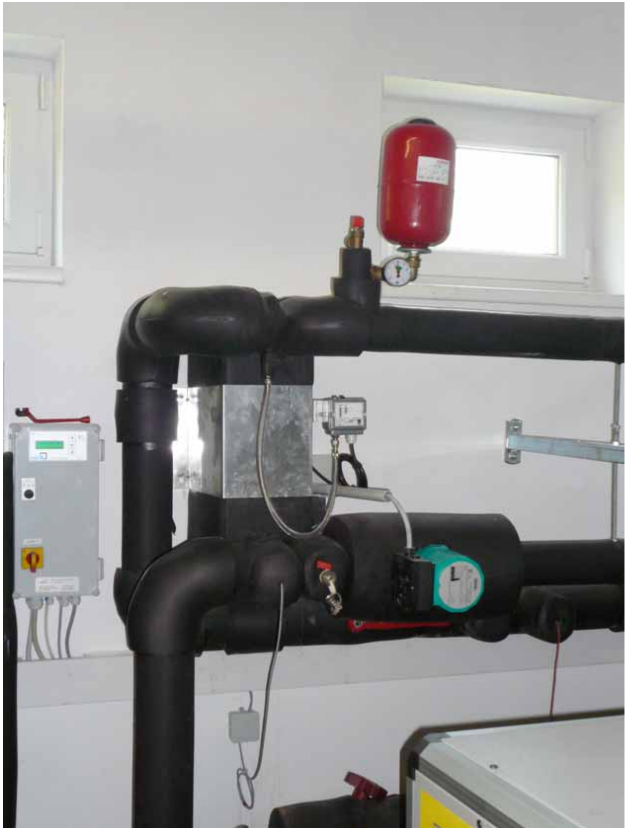
Sicherheitswärmetauscher mit Umwälzpumpe und Ausdehnungsgefäß
