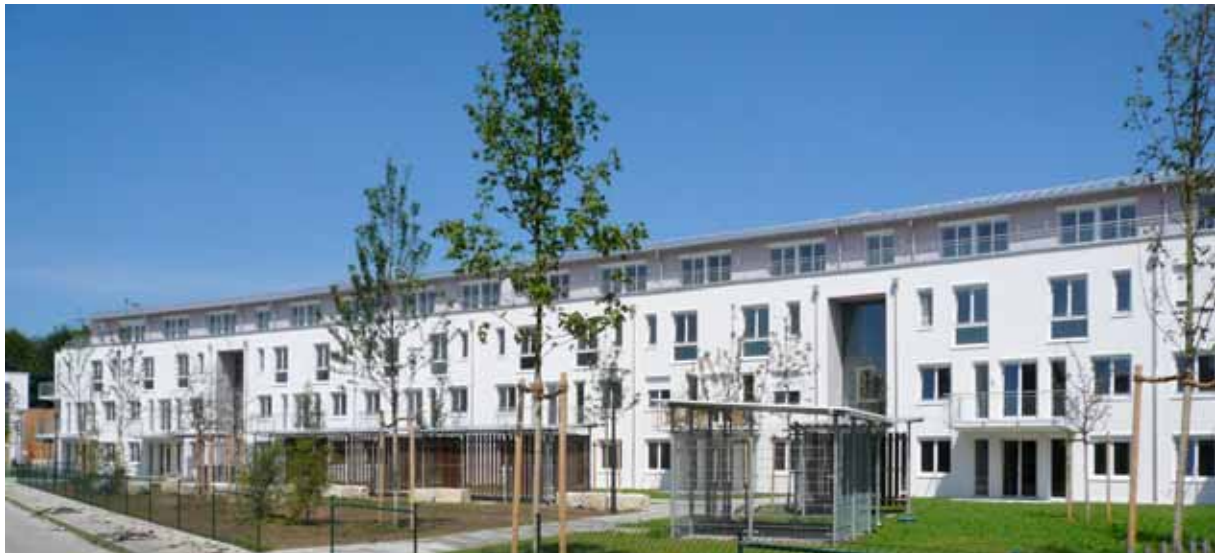
Wohnanlage kurz vor Fertigstellung
