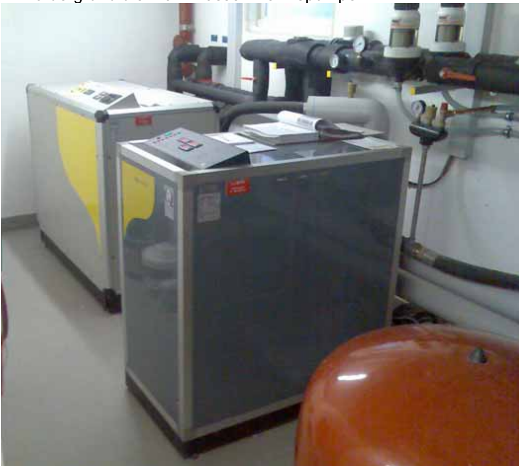
Im Vordergrund die Warmwasser-Wärmepumpe
