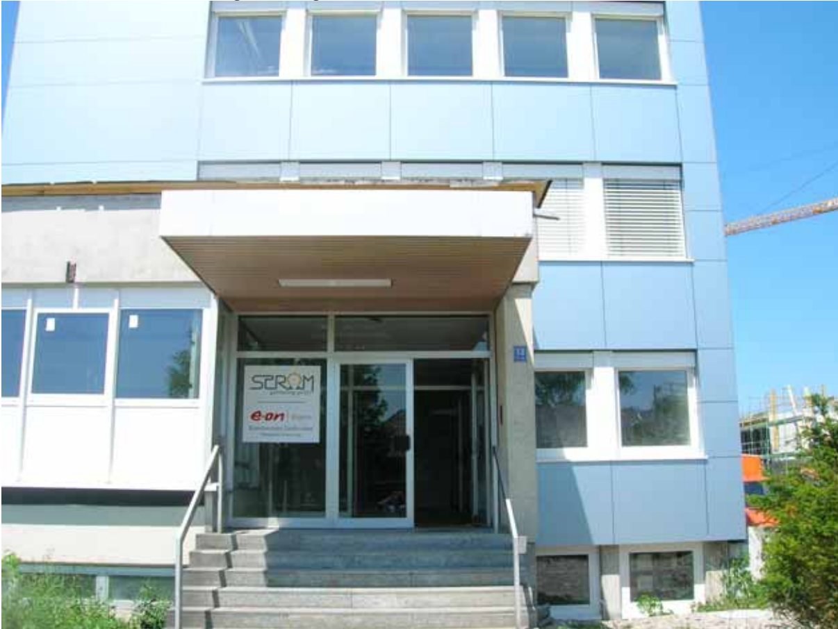
Gebäude kurz vor Fertigstellung
