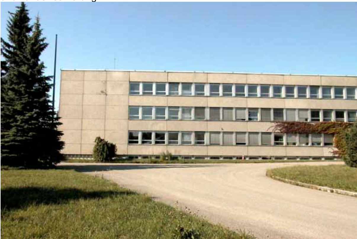
und vor der Sanierung
